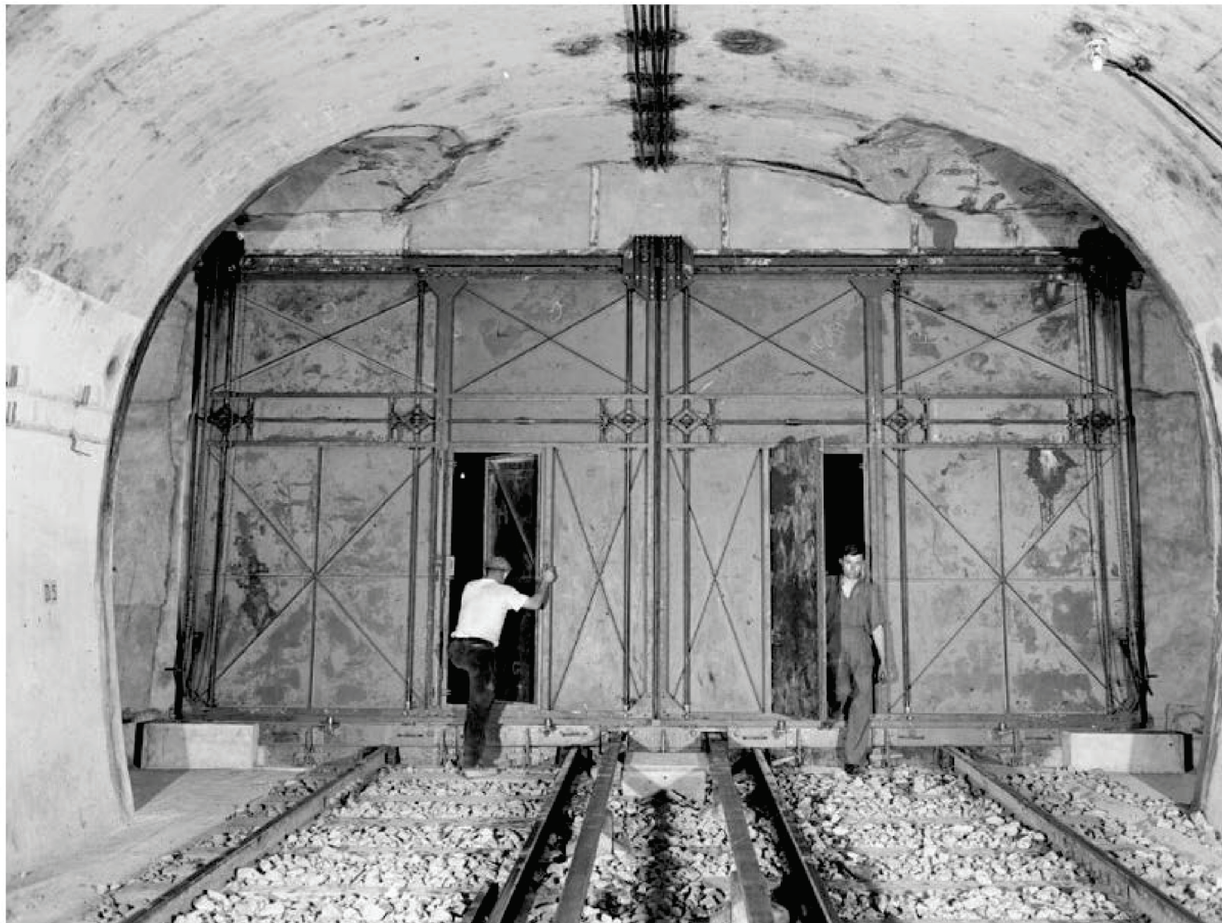
Porte étanche en tunnel créée dans le cadre de la défense passive - 1939 - RAT
