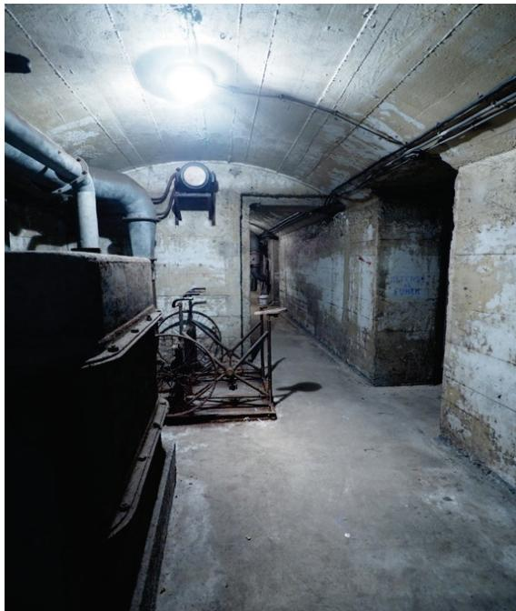
Les deux dispositifs de ventilation et filtration des gaz sont encore en place, dans un état de conservation excellent, malgré l'absence de certaines pièces sur chacun d'eux (pédalier, selle et chaîne des vélos permettant l'activation du dispositif en cas de panne électrique, moteur électrique assurant le fonctionnement de l'appareil, bouteilles d'oxygène et boîtier de branchement de ces bouteilles sur le circuit).
